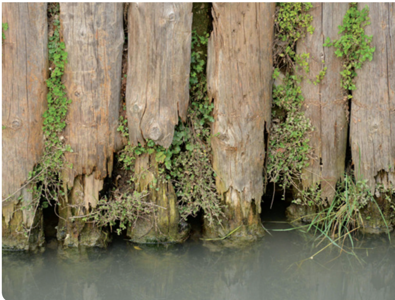
La palizzata che "dovrebbe" contenere il terrapieno. Minata e incontenente in diversi punti
