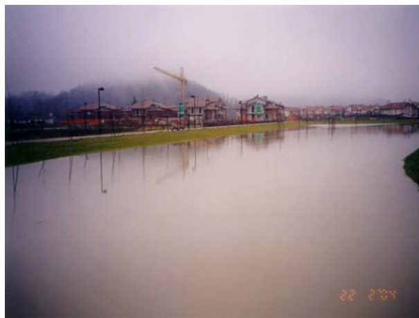
Figura 18. Volume di invaso ricavato in fregio al corso d'acqua ricettore, in periodo secco (a sinistra) e durante una piena (a destra)
