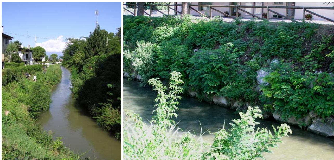
Figura 7. Il torrente Muson dei Sassi nel centro cittadino di Castelfranco e particolare dell'intervento di risezionamento e rivestimento in massi operato dal Genio Civile di Treviso.
