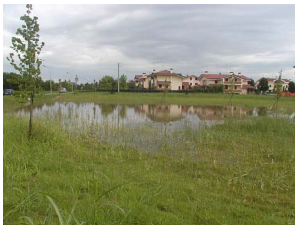
Figura 17. Volume di invaso ricavato tramite depressioni in aree verdi, in periodo secco (a sinistra) e durante una piena (a destra)
