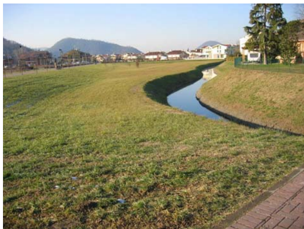
Figura 18. Volume di invaso ricavato in fregio al corso d'acqua ricettore, in periodo secco (a sinistra) e durante una piena (a destra)
