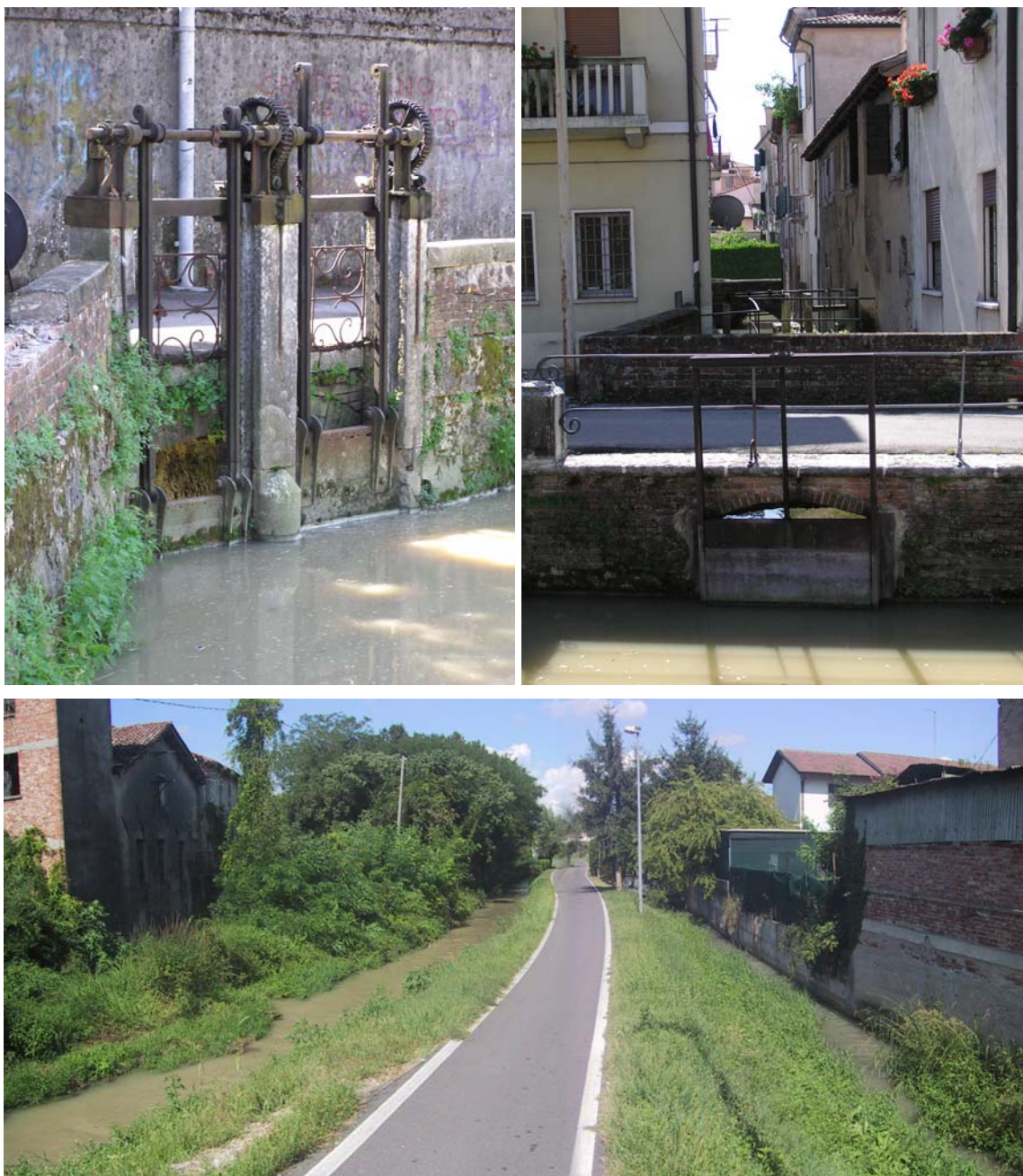
Figura 1. In alto le paratoie Enel (a sinistra) e la paratoia ex-mulino (a destra), che versano le acque dell'Avenale nelle rogge Musoncello e Musonello, per un lungo tratto parallele (foto in basso, vista verso monte da via S.Giorgio, Musoncello a destra e Musonello a sinistra).
