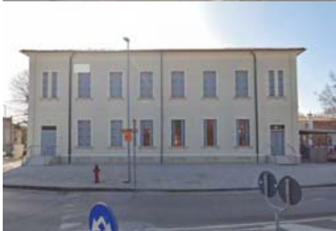
FOTO: l'edificio ristrutturato, prima e dopo i lavori.
